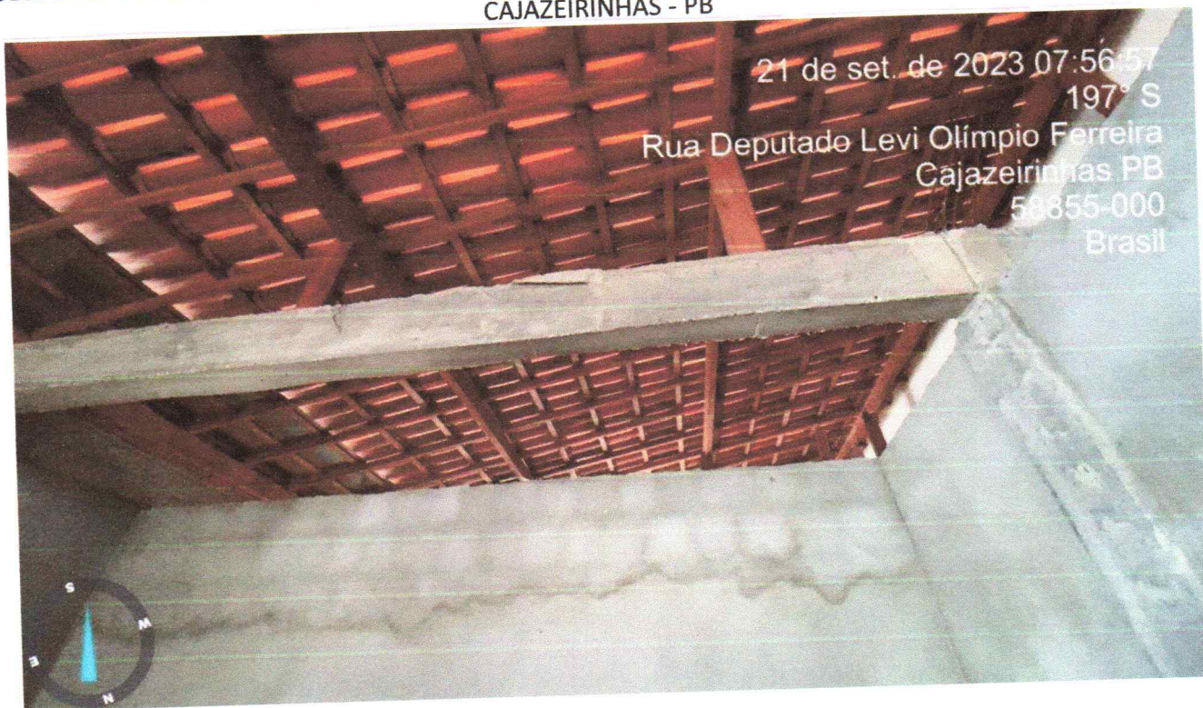
Figura 9 - Execução de coberta.
