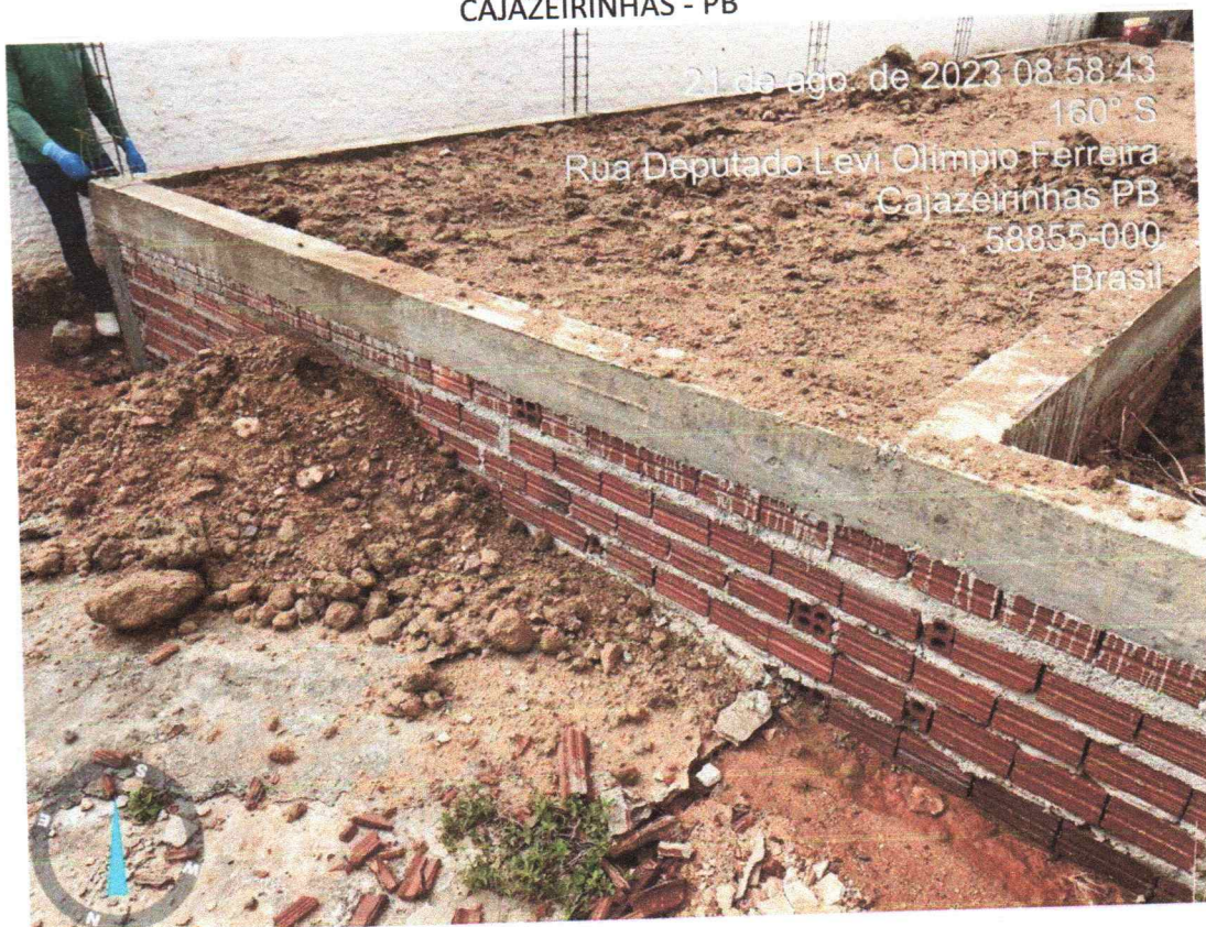
Figura 1 - Viga baldrame concreta e execução de aterro.
