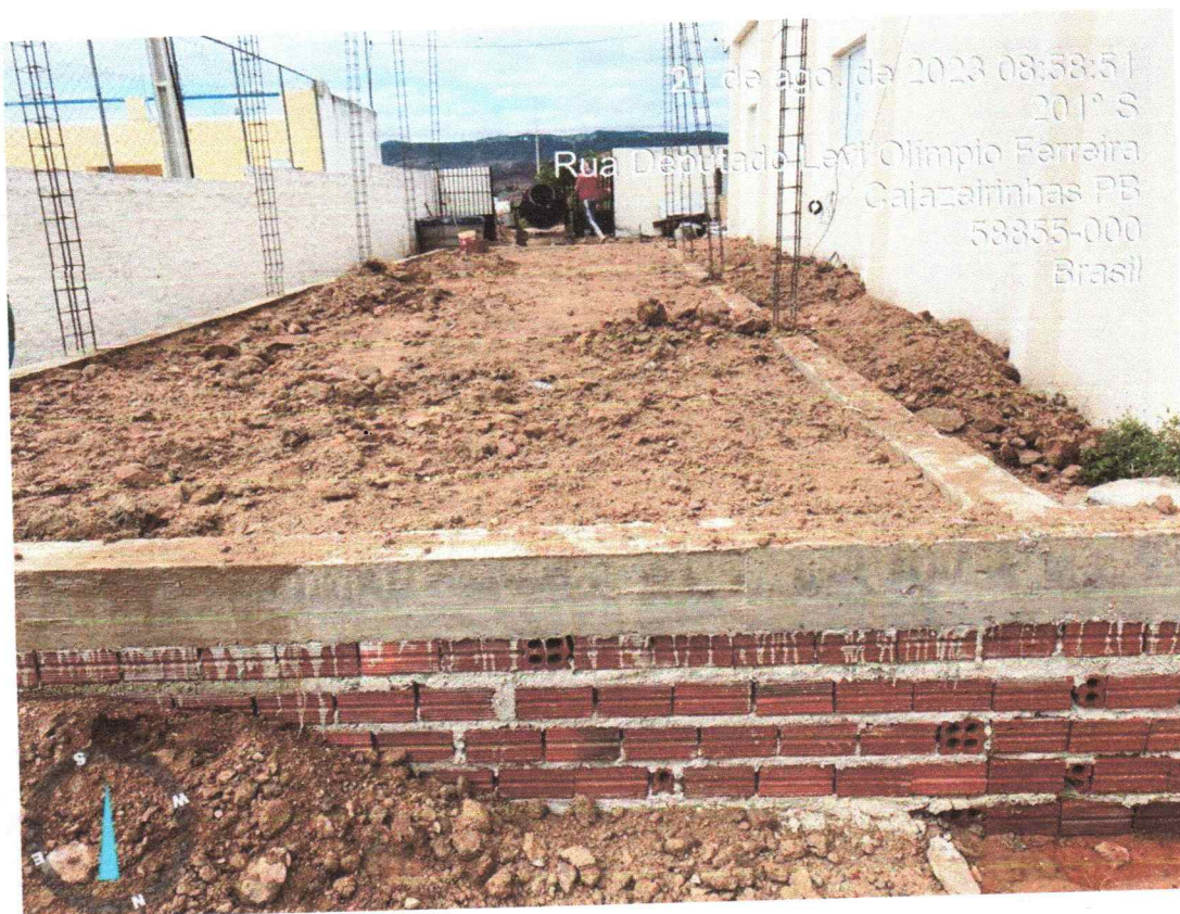
Figura 2 - Aterro sendo executado e armação de pilares.
