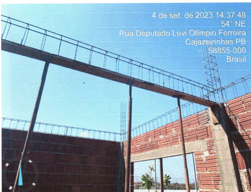
Figura 4 - Armadura de vigas de pavimento superior e execução de fôrmas.
